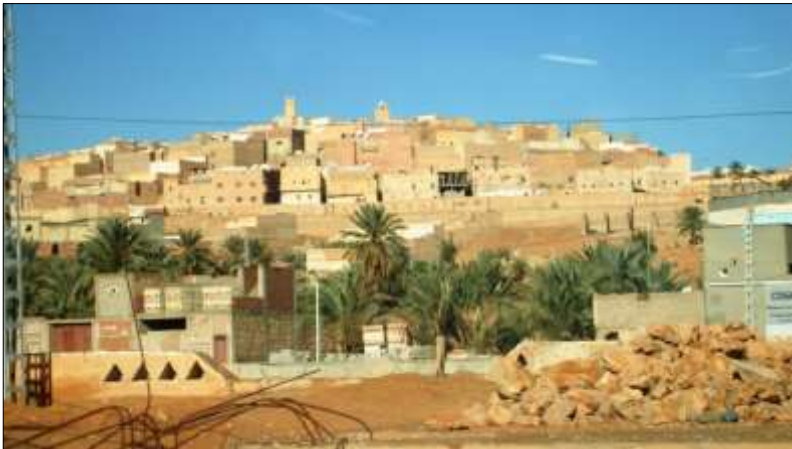
Figure 7 : Les ksour s'élèvent au-dessus des autres quartiers, par leur position surplombante
