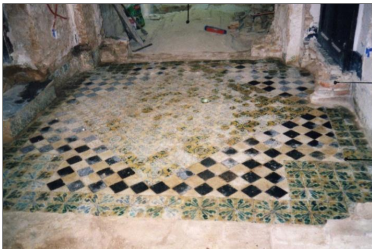
Fig. 4 : Le plancher original de la chambre tiède du bain, au fond la voûte de la chambre chaude.
