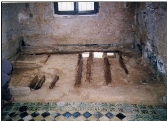
Fig. 7 : L'alcôve découverte dans la chambre tiède du bain. La structure de cette alcôve correspond au relevé réalisé par A. Ravoisié en 1846.
