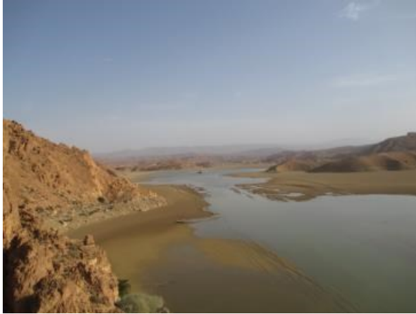
Figure 19 : Le barrage de Foug El Gherza s'envase par courants de densité (Photo. Remini, 2016)
