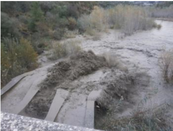
Figure 14 : Soutirage des courants de densité au barrage d'Ighil Emda (Photo. Sonelgaz Derguina)
