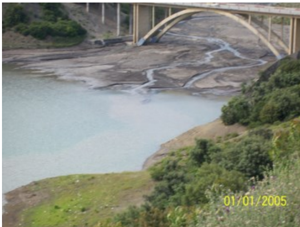
Figure 18 : Le barrage d'Ighil Emda, s'envase par courants de densité (Photo. Ouaret et Remini, 2005)
