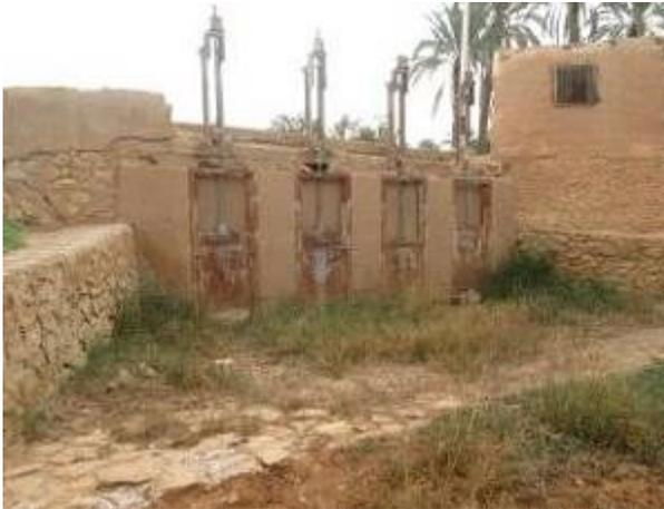
**Figure 12 : Première batterie de vannes coulissantes (Remini, 2014)**
