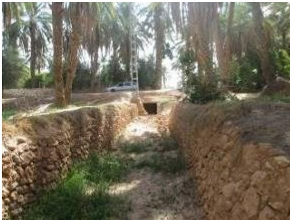
**Figure 23 : Seguia reliant la sortie de la vanne à portes coulissantes (Photo. Remini, 2014)**
