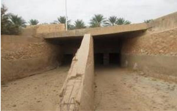
**Figure 13 : Partie avale de la première batterie de vannes a portes coulissantes (Remini, 2014)**
