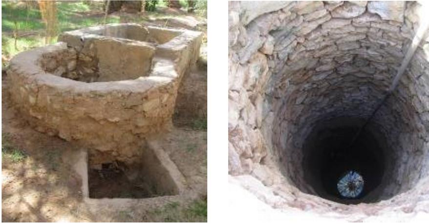
**Figure 25 : Puits à double fonction : Puisage et recharge de la nappe dans les oasis d'El Guerrara (Photo. Remini, 2013)**
