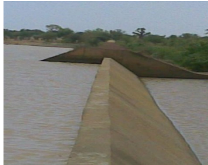
Figure 4 : Vue générale du mini-barrage de Wourowourokou (Source : HOUNTONDI, Babilas)
