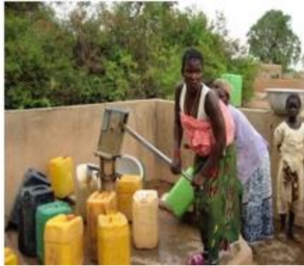
Photo 1 : Forage doté de pompe manuelle à Ségbé (source : auteurs, 2019)
