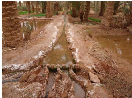
Figure 7 : Kasria secondaire de la foggara d'Irsan
