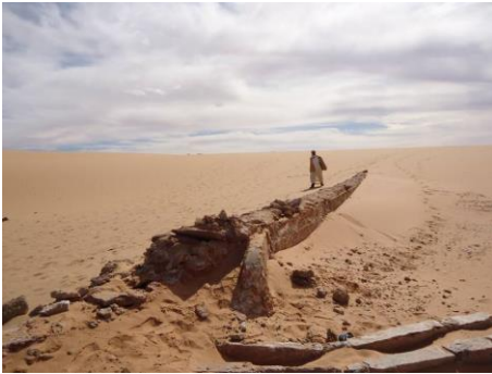
Figure 6 : Canal principale de la foggara d'Irsan (photo. Auteurs, 2013)
