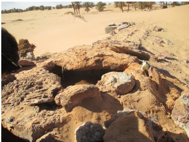
Figure 3 : Seguia couverte par des roches plates, un moyen de lutte contre l'ensablement
