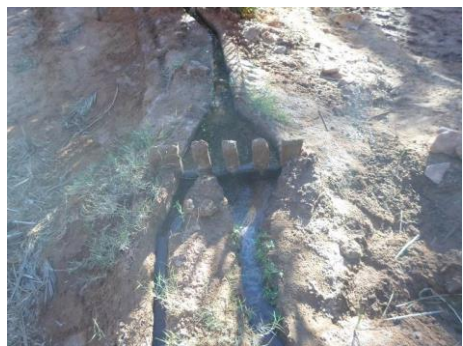
Figure 9 : Kasria multiple de la foggara d'Irsan
