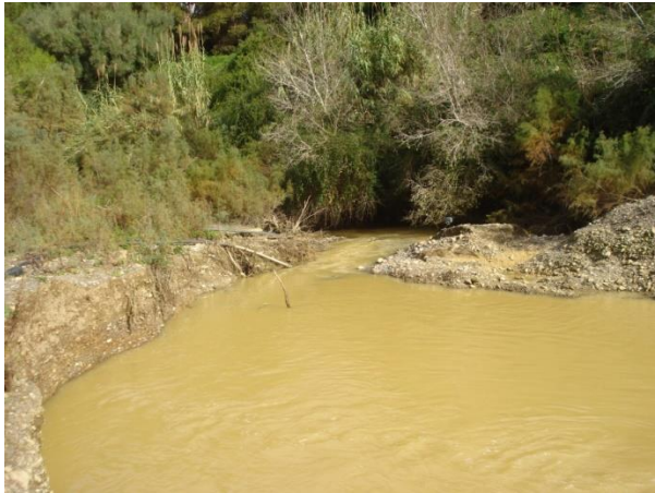
Figure 15 : Eau chargée en sédiments fins évacuée par la vanne de fond (Photo. Remini, 2011)
