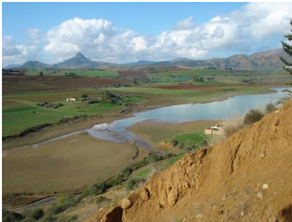
Figure 10 : Régression de la capacité du barrage réservoir de Boukourdane suite au dépôt de vase (Photo. Remini, 2011)
