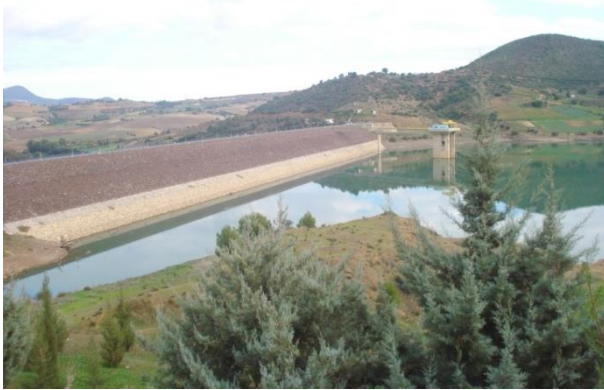
Figure 2 : Digue en enrochement du barrage réservoir de Boukourdane (Photo. Remini, 2007)
