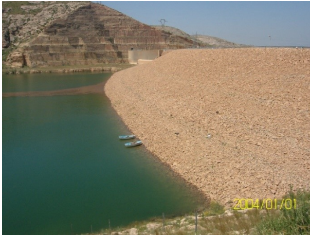
Figure 2 : Vue de la digue du barrage de Gargar (Benfetta, 2004)
