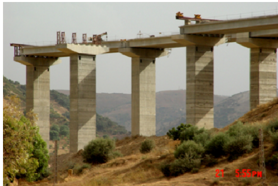
Fig. 1. Viaduc de Bouira (Algérie) en construction.
