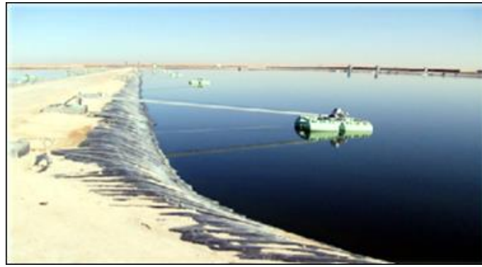
Figure 6. Station de lagunage Airé de la ville d'Ouargla.
