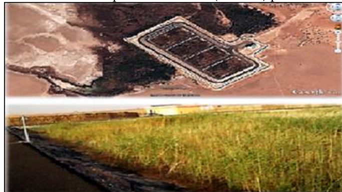
Figure 5. Station de lagunage à filtre planté de roseau N'Goussa de la ville d'Ouargla
