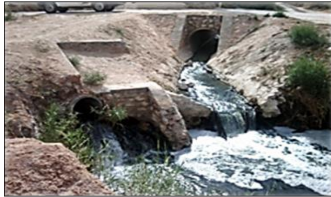
Figure 2. Rejet de la ville de Touggourt (Canal d'Oued Righ)
