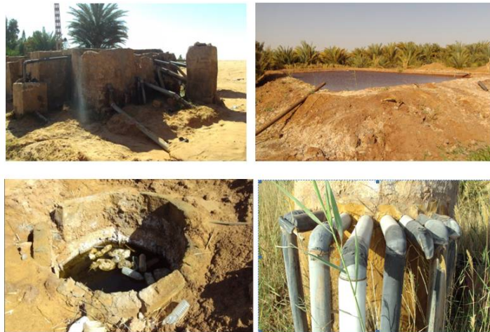
Figure 9. Mauvais état du système d'irrigation (Zegait, 2011)
